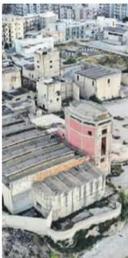
L'AREA L'ex distilleria
