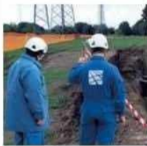
▲ L'impianto Tecnici al lavoro
