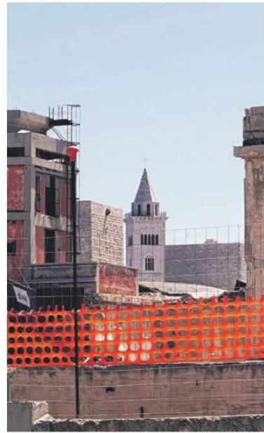
LA DEMOLIZIONE Il campanile della cattedrale e le prime torri del castello emergono alla vista dopo le prime demolizioni. Si comincia ad avere la percezione del bel colpo d'occhio che ci sarà dal lungomare di ponente
